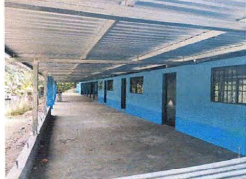
Foto 2: ENTORTADO DE CEMENTO DE MODULO 2
