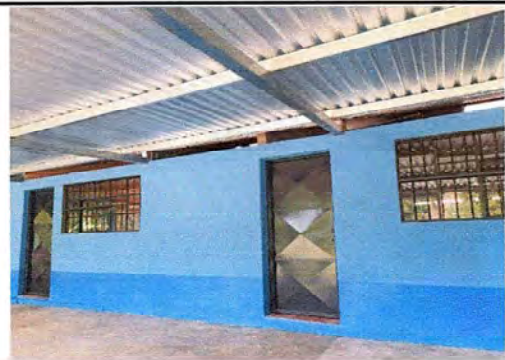
Foto 4: PUERTAS Y VENTANAS DE MODULO 2
